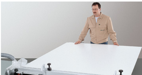
Выровнять плиту и обрезать с одной стороны.
